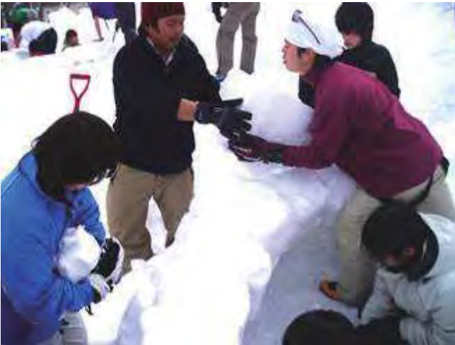
イグルー作り3:2段目は少し前にせり出すように積み上げていきます。
